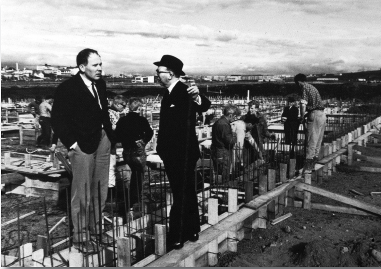
Maggi Jónsson, tæknifræðingur og síðar arkitekt og byggingarstjóri Háskólans (til vinstri) og Ármann Snævarr háskólarektor á grunni Norræna hússins meðan það var í byggingu.
