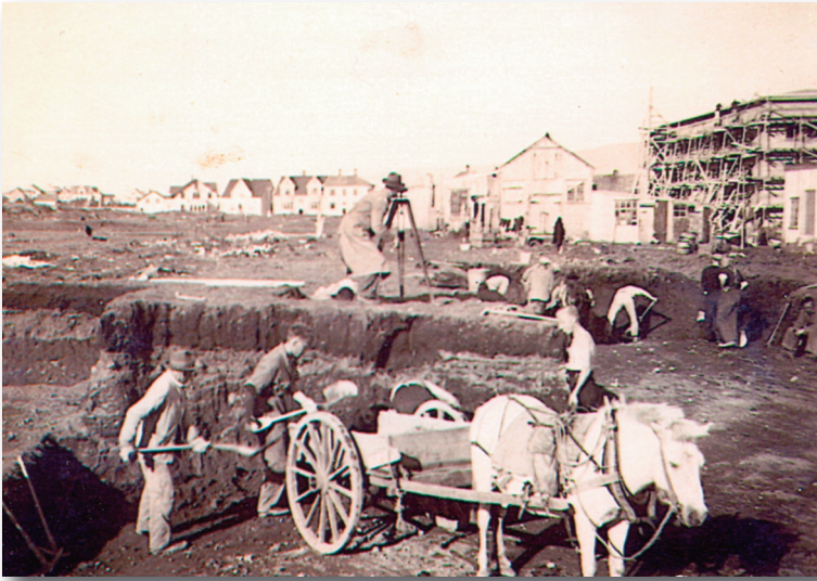
Grafið fyrir Háskólabyggingunni með gamaldags tækni. Til hægri er hús Atvinnudeildar girt vinnuþöllum.
